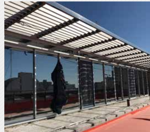
Vista parcial del salón del restaurante en el 9° piso y de la futura azotea parquizada
